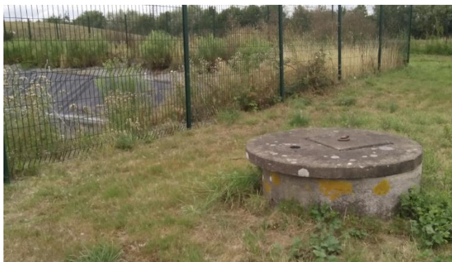
Le puits n°1
