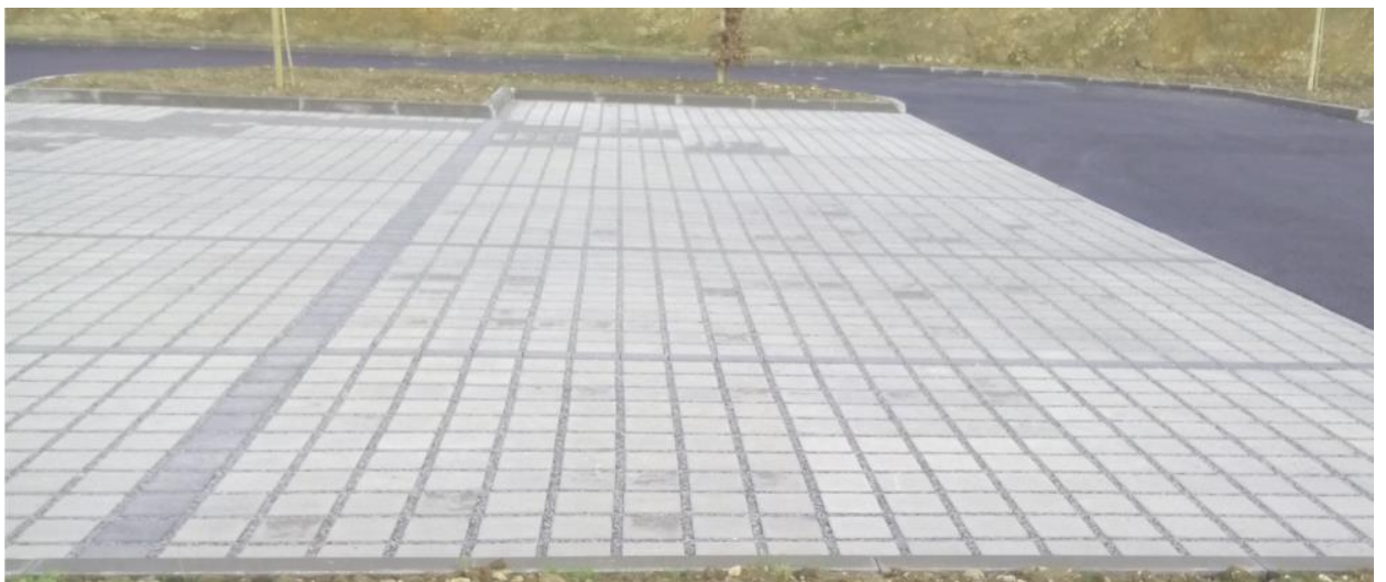
2 photos : Exemple de places de stationnement semi-perméables pour véhicules légers.
