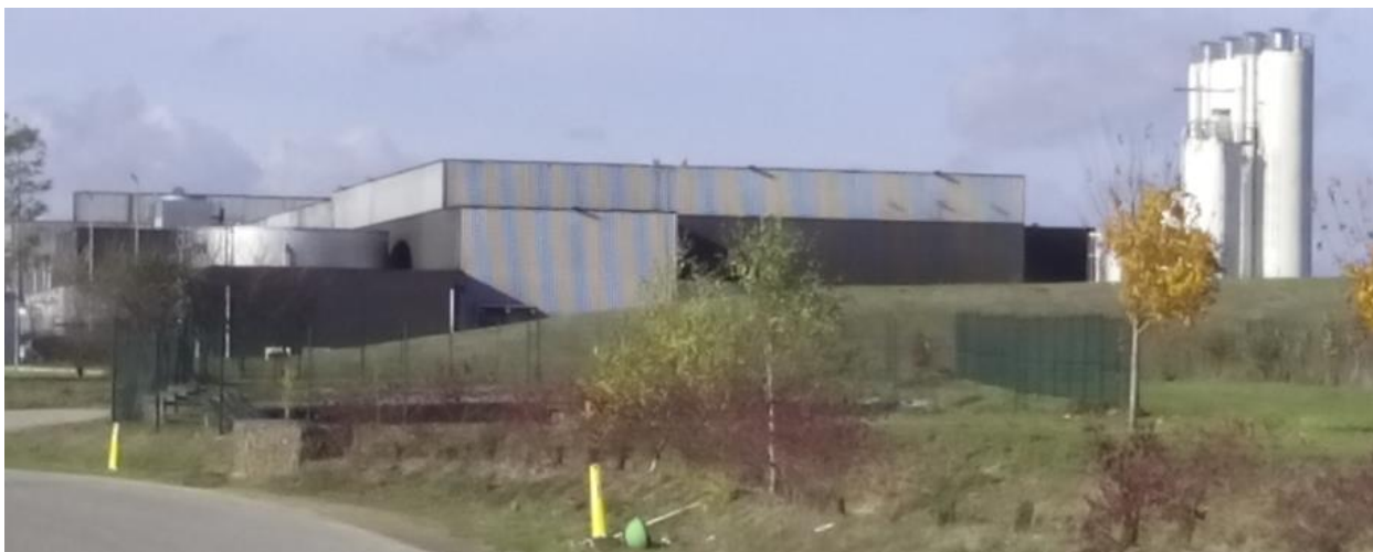
Le bâti de la société « Vandemoortele » à proximité de l'extension du PA.
