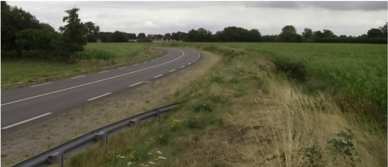
Vue lointaine sur la RD 777 depuis la limite Nord – Est du projet.
