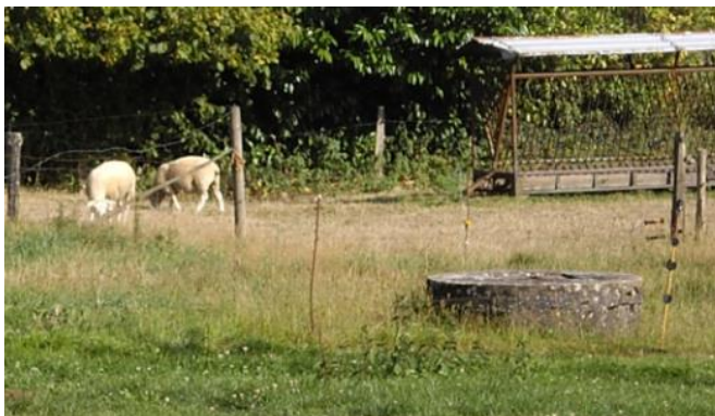
Le puits n°3
