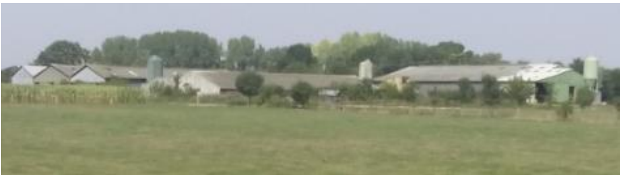
Les bâtiments d'élevage au lieu – dit « La Fleuriais ».
